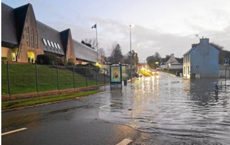
Vendredi soir, l'affluent du Spernot qui coule en amont de la prison s'est déversé, en partie, sur la route, alors qu'un conduit sous-terrain lui permet normalement de passer en dessous.
