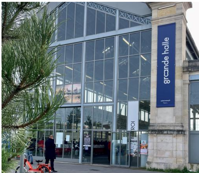
Les Rencontres auront lieu à l'Octroi, anciens abattoirs. En phase avec le manifeste du mouvement qui veut faire mieux avec moins, et donc réhabiliter plutôt que construire. Photo Lysiane Ganousse
